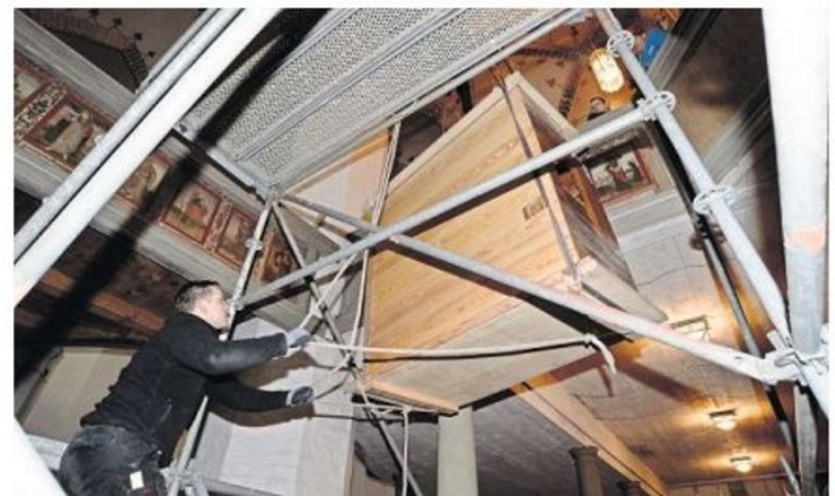
Bloß nicht anecken. Mit Seilen manövriert Orgelbaumeister Thomas Lang den am Kettenzug hängenden Spieltisch.
